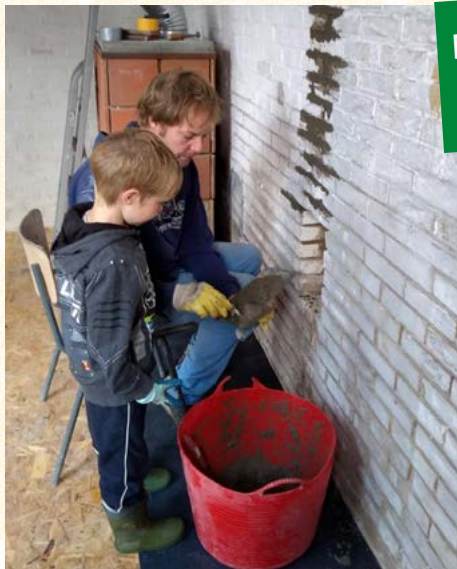
MULTIFUNCTIONELE ONTMOETINGSRUIMTE 'HET POMPHUIS'
