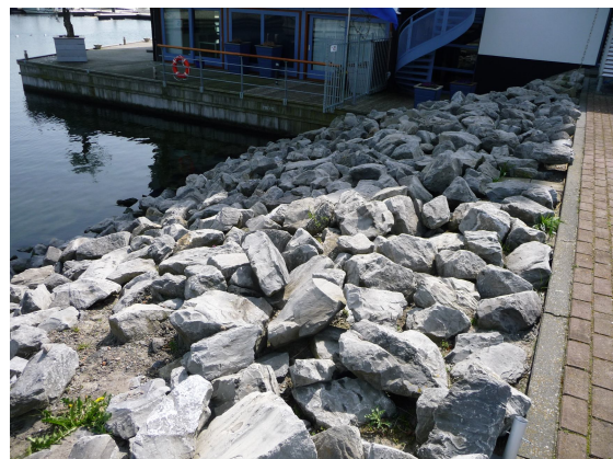
Een natuurlijk en aangenaam dijktalud
