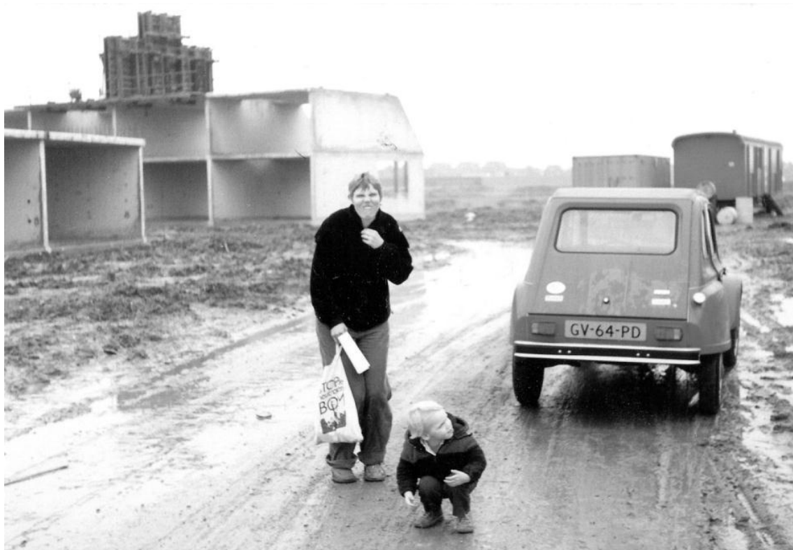
FOTO straat in aanbouw
