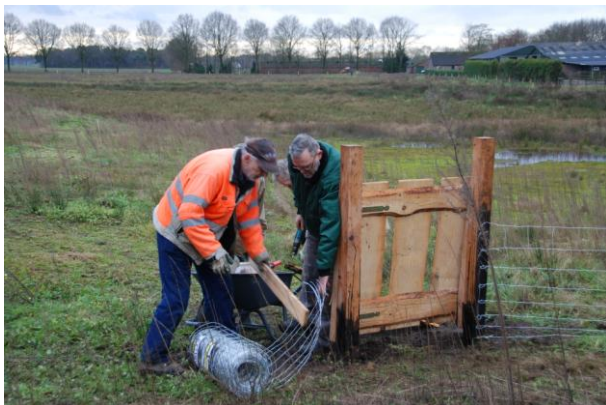
Looppoort plaatsen in uitbreiding
